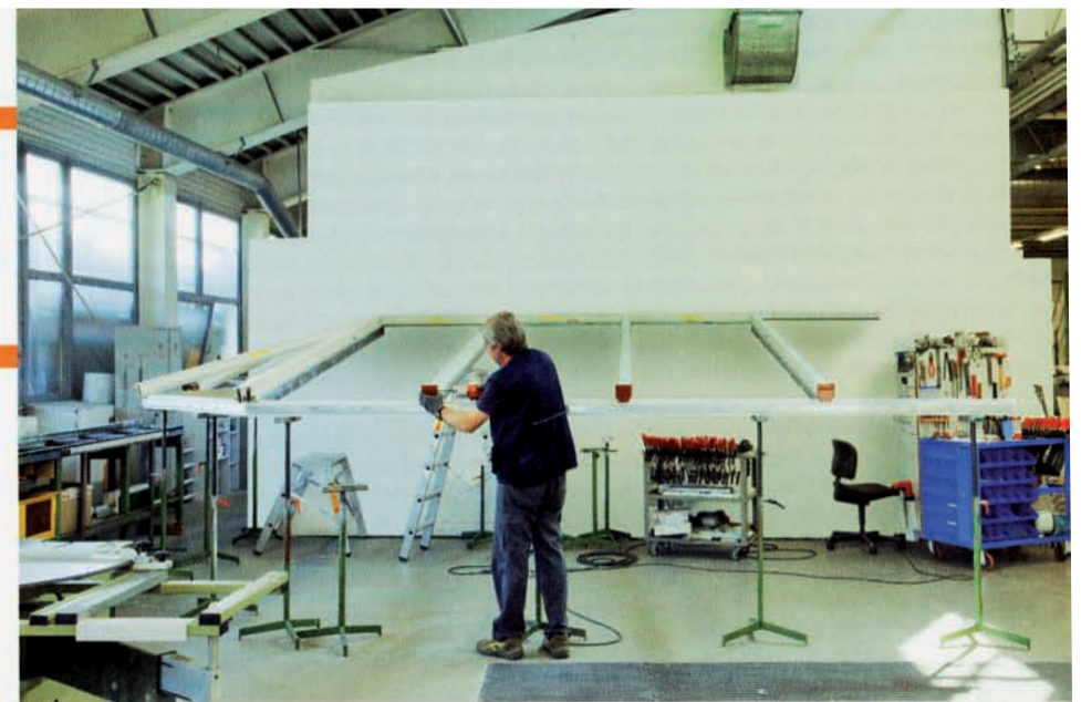
Komplexere Dachkonstruktionen werden vor der Auslieferung in der Produktion aufgebaut.
