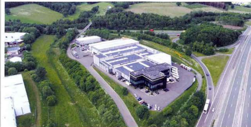
Das Firmengelände mit dem repräsentativen Verwaltungsbau liegt unmittelbar und damit besonders publikumswirksam am Autobahnkreuz Olpe an der A45. Foto: Sunflex
